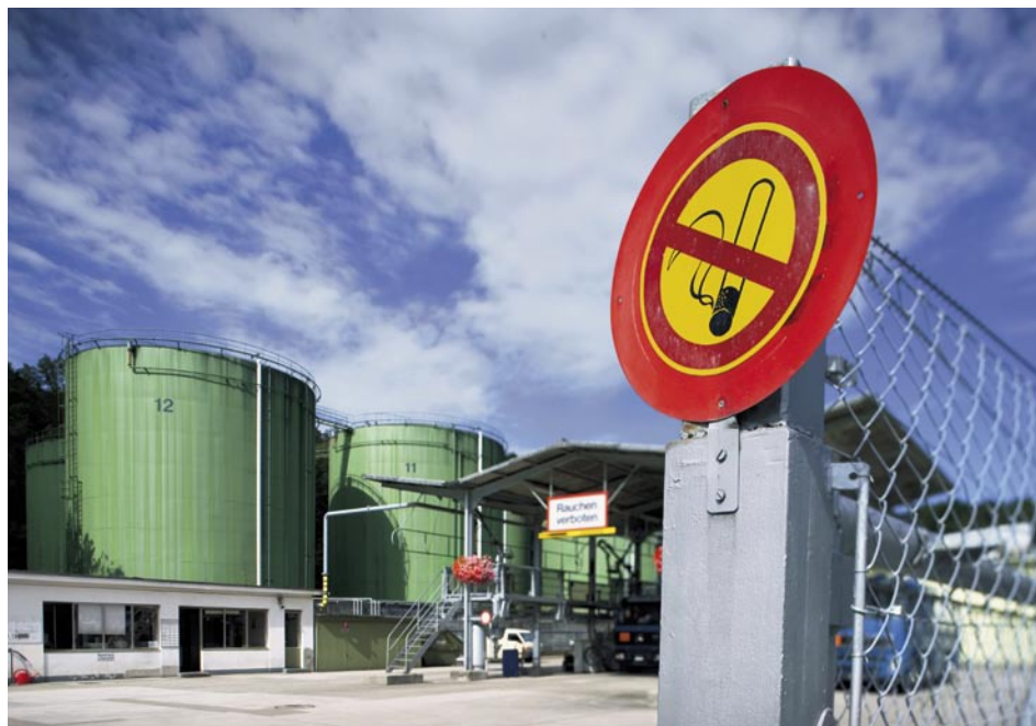
Als Folge des Hurrikans «Katrina», der vor allem in den USA zu erheblichen Störungen in der Treibstoffversorgung führte, wurde der Erdölbranche in der Schweiz im Herbst 2005 die Möglichkeit gewährt, bei Bedarf im Inland Pflichtlager einzusetzen (im Bild: Tankanlage Birmensdorf). Bild: Keystone
