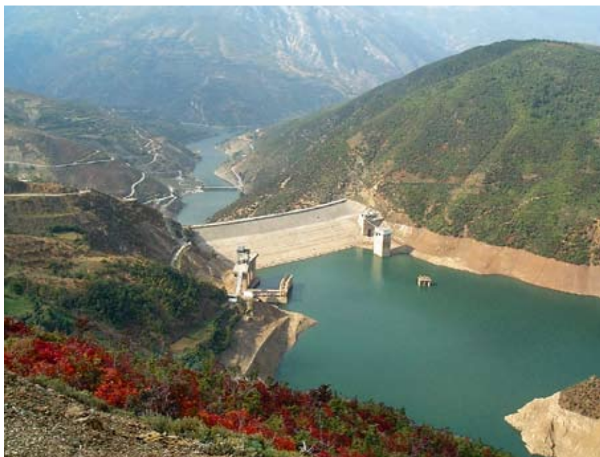
La centrale hydroélectrique de Fierza, en Albanie, a été assainie en faisant appel au savoir-faire suisse et au financement du Seco, qui a engagé 12 millions de francs dans le projet.
