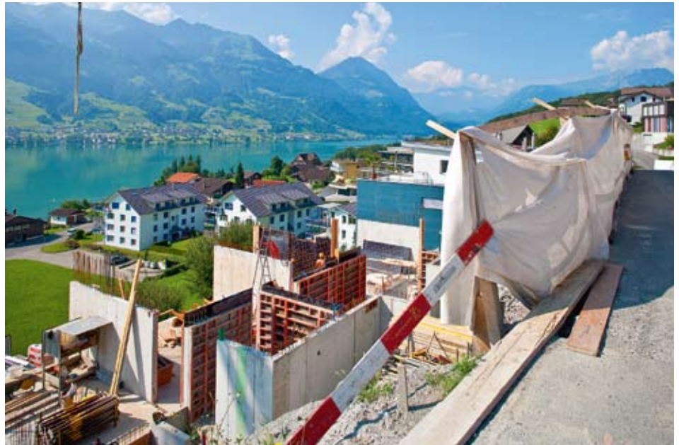
La stratégie à long terme 2012+ du canton d'Obwald a, dans l'ensemble, été un succès. Cela apparaît nettement dans l'indice des ressources de la nouvelle péréquation financière, qui est monté de 67,2 à 74,0 entre 2008 et 2011. En illustration: chantier à Sarnen. Photo: Keystone
