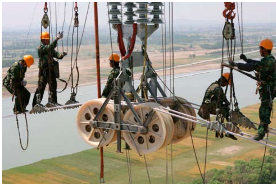
Les besoins mondiaux en infrastructures sont immenses, que ce soit dans les pays industrialisés, émergents ou en développement. L'offre suisse est, en retour, remarquable en ce domaine. En illustration: construction de lignes à haute tension en Chine.
