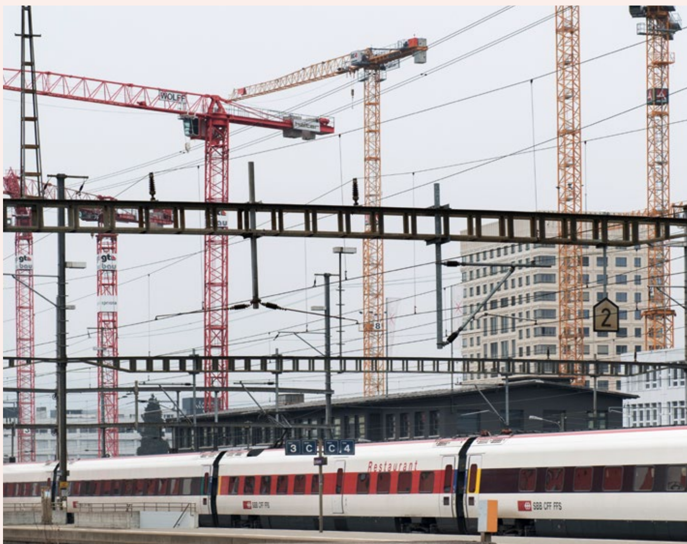
Les constructions se font là où les connexions au réseau de transport sont bonnes. Des travaux à la gare de Schlieren (ZH) en 2013.
