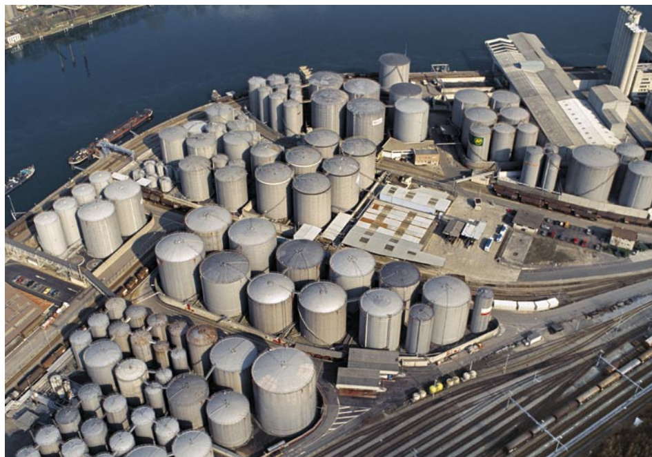
Die Schweizer Wirtschaft weist eine niedrige Energie- und Erdölintensität auf. Dennoch liegt der Schweizer Pro-Kopf-Erdölverbrauch 8% über dem EU-Durchschnitt, hauptsächlich weil Erdöl mehr für Heizzwecke eingesetzt wird als anderswo. Im Bild: Öllager im Rheinhafen Basel.
