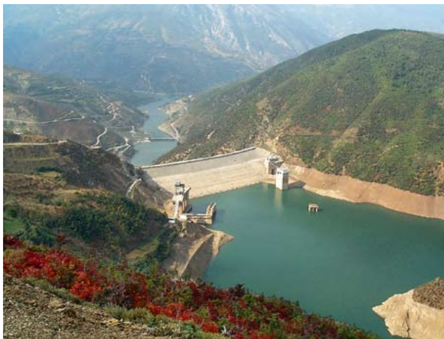
Das Kraftwerk Fierza in Albanien (im Bild) wurde mit Schweizer Know-how und Finanzierung des Seco in der Höhe von rund 12 Mio. Franken saniert.
