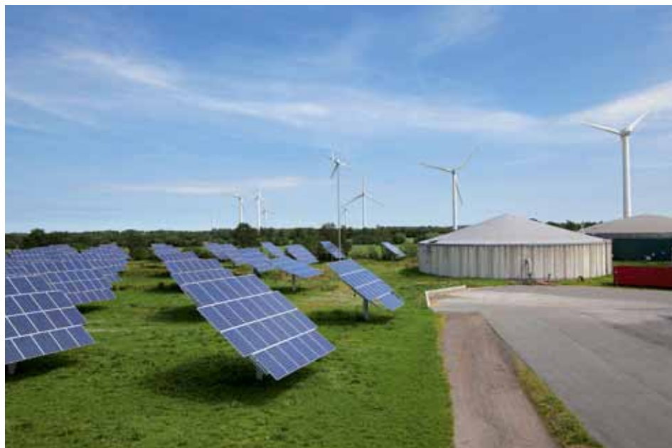
La transition énergétique allemande constitue un programme politique ambitieux pour l'environnement et l'économie, qui annonce aussi des changements importants pour les particuliers. Les énergies éolienne et solaire représentent la nouvelle épine dorsale de la production électrique. En illustration: parc solaire et éolien dans le nord de l'Allemagne.
