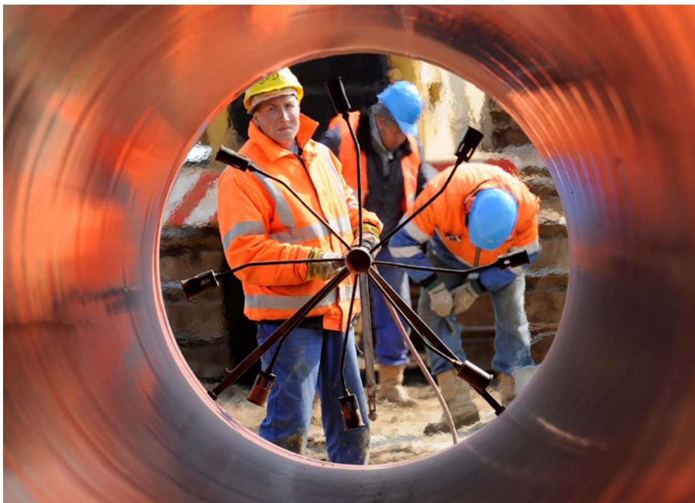
Erdgas ist in Europa nach wie vor wichtig für die Stromproduktion. Bau einer Pipeline in Mecklenburg-Vorpommern.
