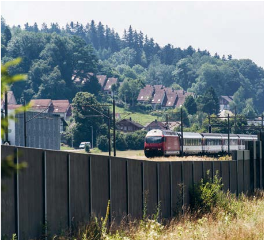
Einen Grossteil der externen Kosten im Schienenverkehr verursachen Lärmemissionen. Schutzwand im bernischen Oberwangen.
