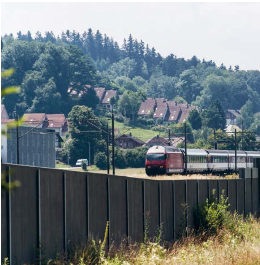
Une grande partie des coûts externes générés par le rail proviennent des émissions de bruit. Mur de protection à Oberwangen près de Berne.
