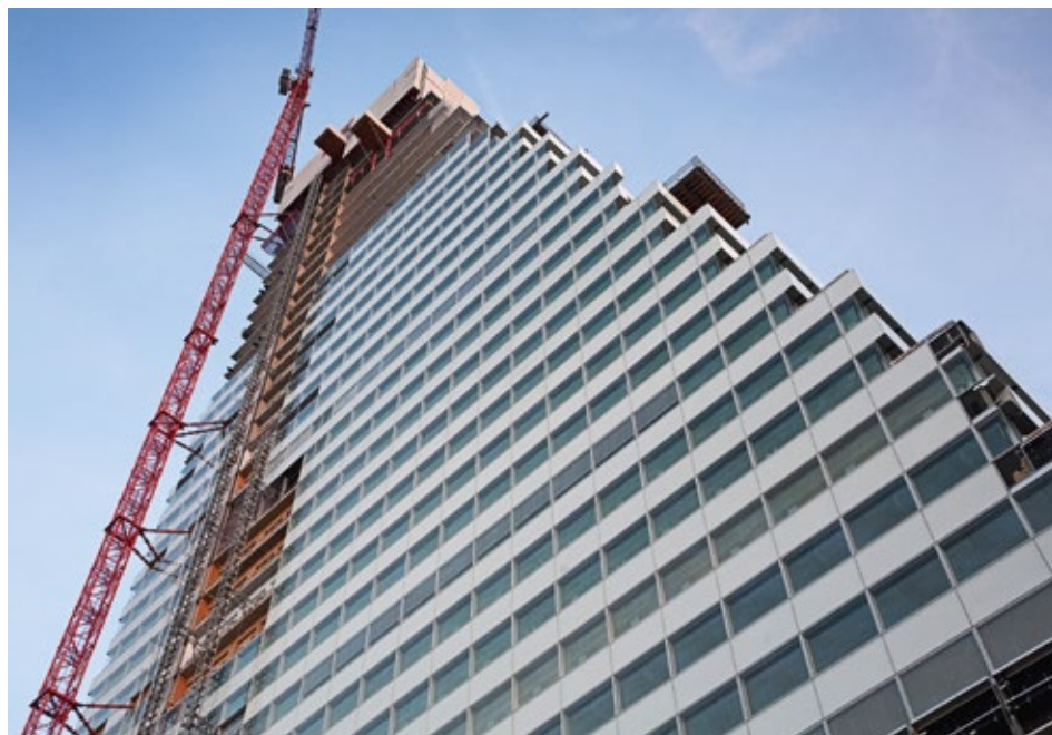
Chantier de la tour Roche. La croissance économique suisse a fait preuve de solidité après la crise qui a touché le monde.
