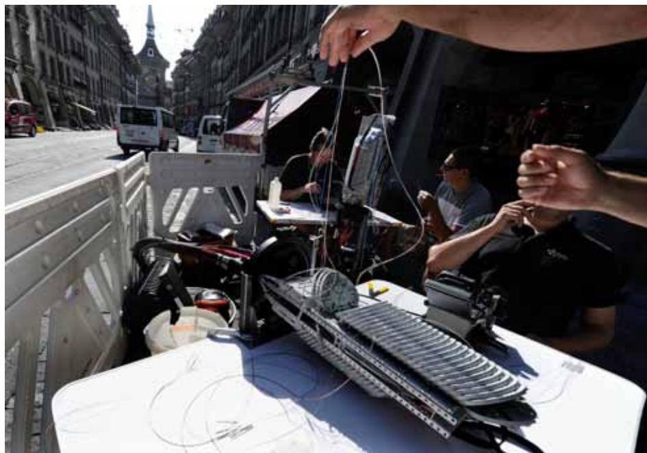
Un technicien épisse des fibres optiques sur un chantier de la vieille ville de Berne. Le développement de tels réseaux permet à un nombre croissant de clients d'être desservis avec des débits qui se mesurent en gigabits par seconde.
