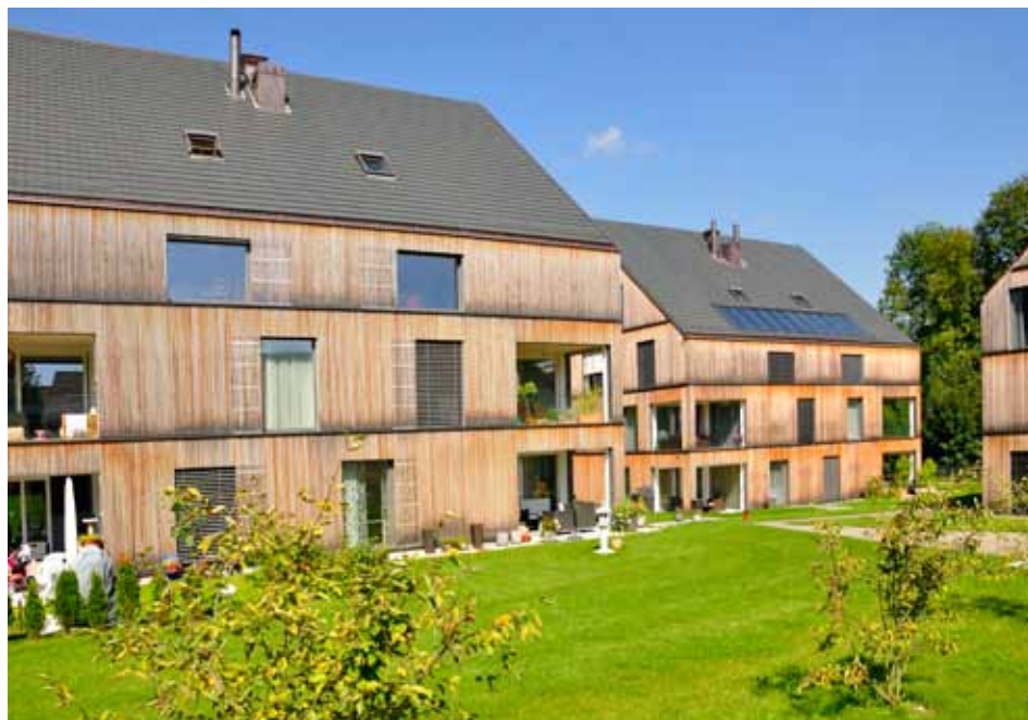
En Suisse, les logements sont, en règle générale, d'excellente qualité et bien entretenus. En outre, la construction de nouveaux objets est florissante, comme l'illustre ce lotissement en bois à Effretikon (ZH).
